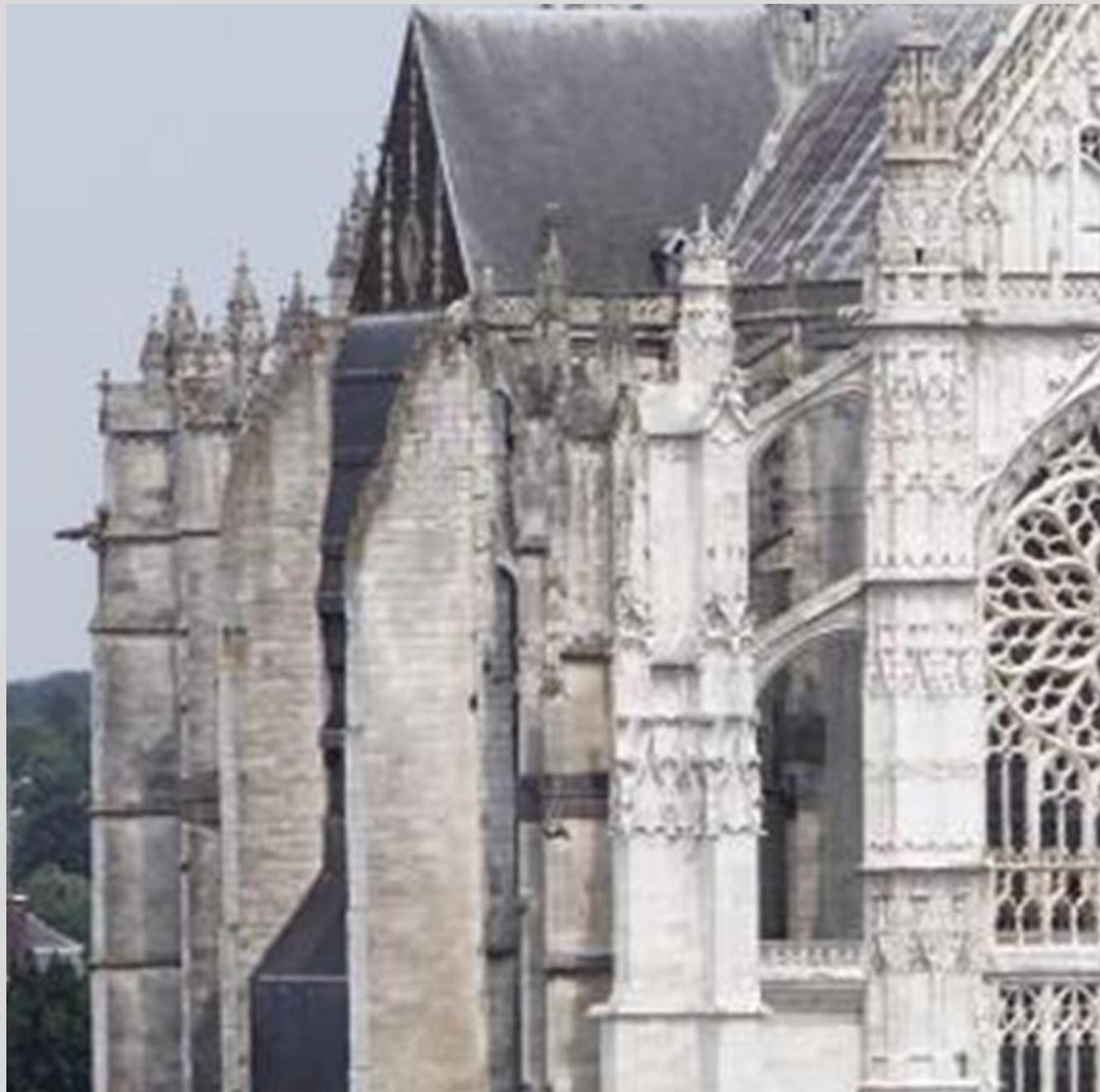
Dans les années 1960, des tirants de fer jugés inesthétiques et inutiles sont retirés! 20 ans plus tard des fissures apparaissent.... On étaye et on remet les tirants
